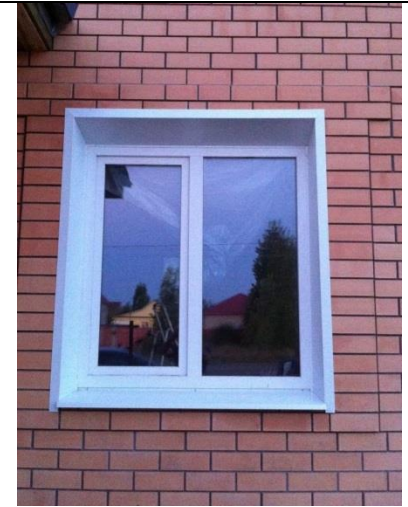
Зовнішні відкоси (шпаклювання + фарбування)
