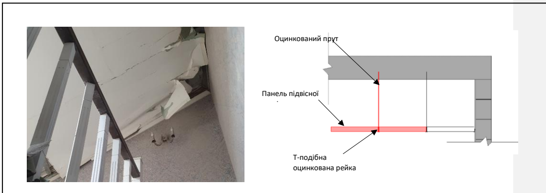
Рисунок 5. Ремонт підвісної стелі
